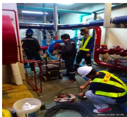
ภาพที่ 2.2-14 การตรวจสอบการทำงานของเครื่องสูบน้ำในบ่อหมุนน้ำ
