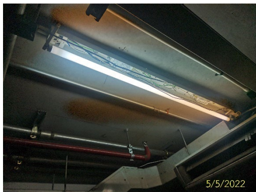
การเปลี่ยนหลอดไฟส่องสว่างพื้นที่ส่วนกลาง
