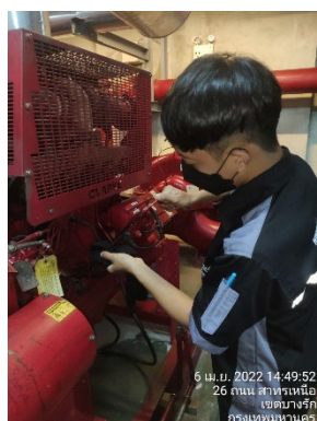
ตรวจสอบระบบป้องกัน/ระงับอัคคีภัยและระบบเตือนอัคคีภัย
